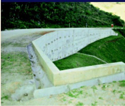
Projeto de Estabilização de Encostas em Margem de Rodovia
